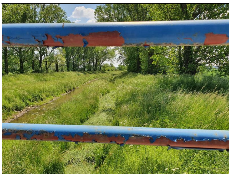
Poškozený nátěr vodorovné výplně svodidla
