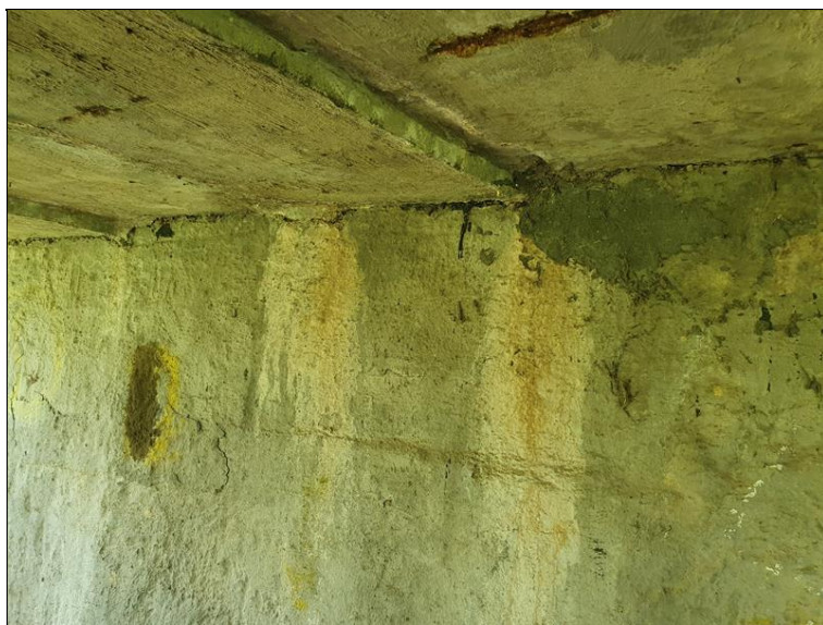
Zatékání z úložného prahu na OP1.
