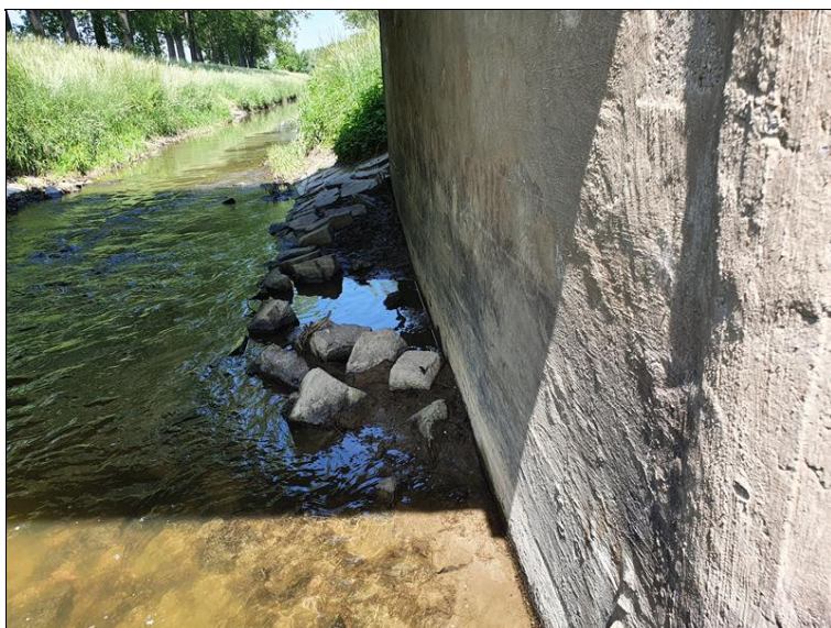
Rozpad dlažby u pilíře 3
