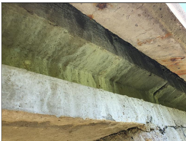
Zatékání na NK z prostoru římsy
