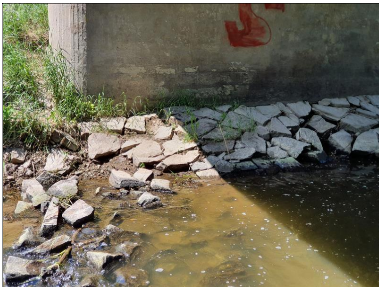
Rozpad dlažby u pilíře 2
