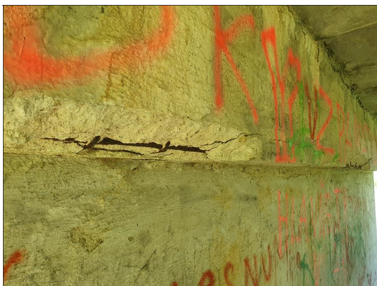
Koroze výztuže úl.prahů, odpadávání krycí vrstvy betonu
