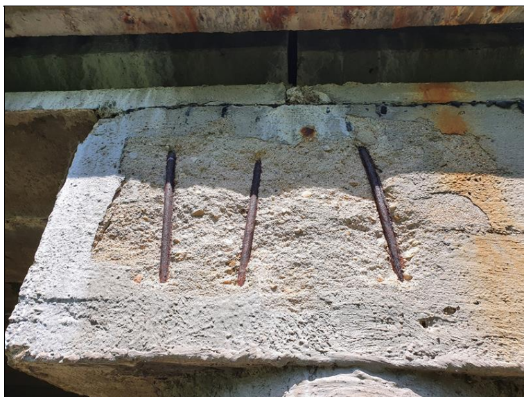
Koroze výztuže čel úl.prahů podpěr
