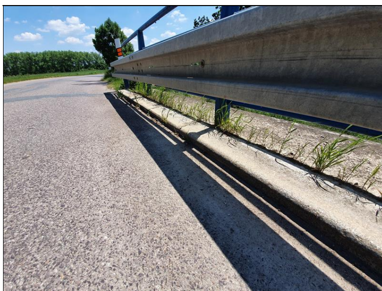
Pravá římsa, vegetace za obrubou, převrstvená vozovka
