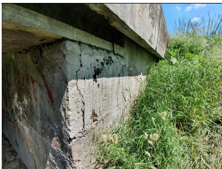
Křídlo 4P, trhliny, povrchový rozpad betonu
