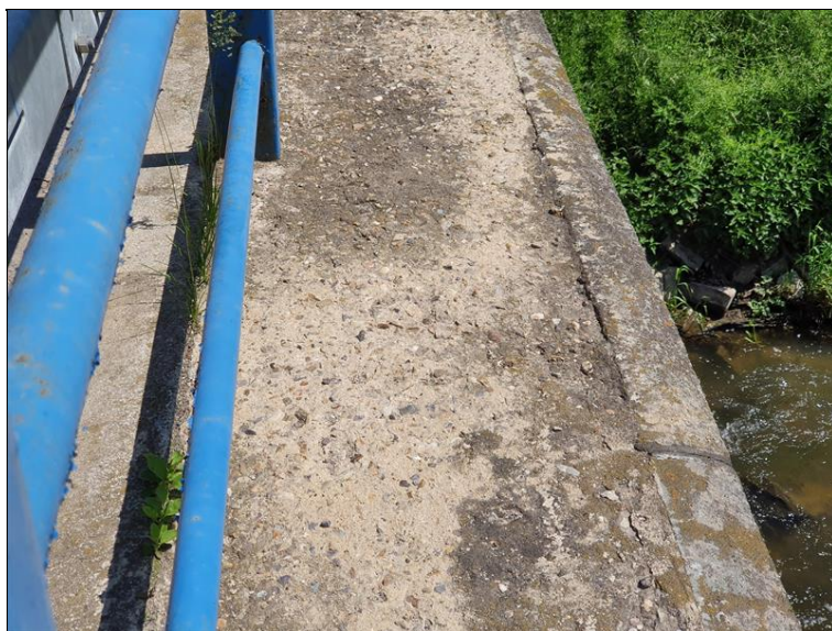
Pravá římsa, povrchový rozpad betonu
