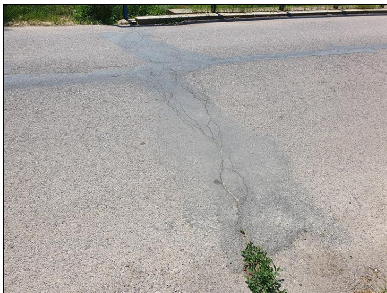
Trhliny ve vozovce
